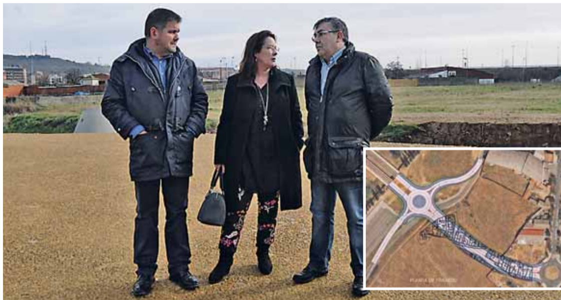
La concejala de Urbanismo, Belén Martín-Granizo, en la obra con un técnico municipal y el responsable de Coysa. Al fondo, el tramo de la 2ª fase del proyecto que está pendiente de la correspondiente consignación presupuestaria.
