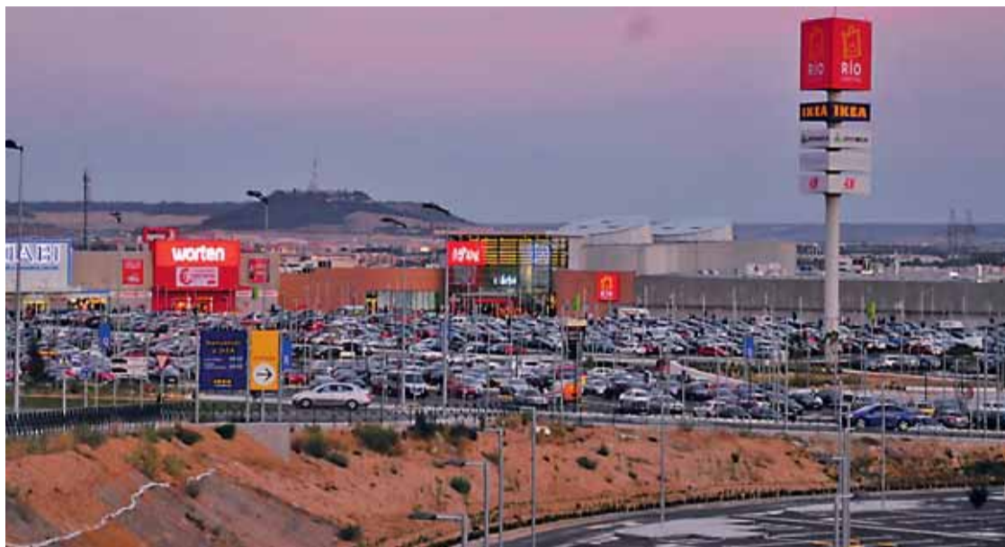
Vista general de la zona oeste del centro comercial 'Río Shopping' en Arroyo de la Encomienda, Valladolid.
