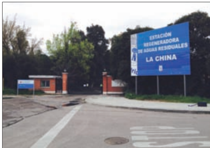
La entrada principal de la depuradora municipal
