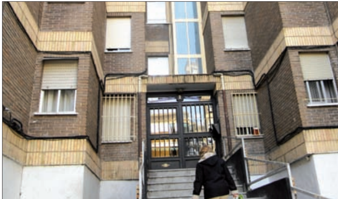
Uno de los ascensores que se han instalado en comunidades de la región
