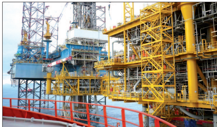
Almacén de gas Castor, frente a la costa de Castellón
