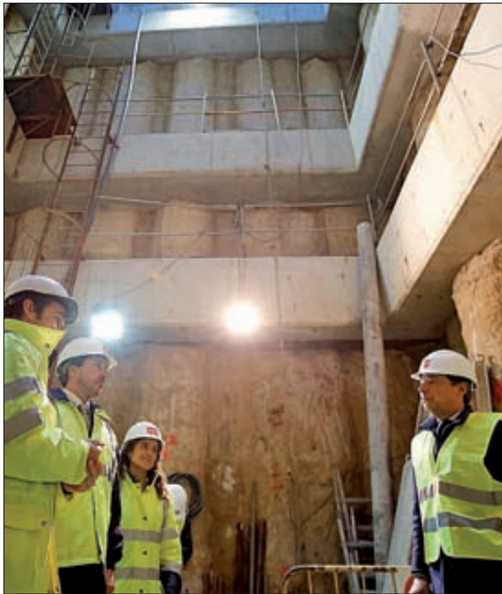
Las obras para la llegada del Metro siguen adelante
