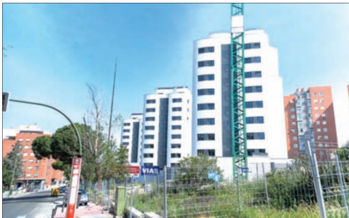
Fachada de las torres con las nuevas viviendas de los realojados GENTE
