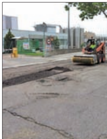
Las obras en marcha
