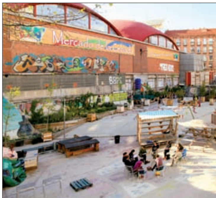
Estado actual del solar, reactivado por los propios vecinos
