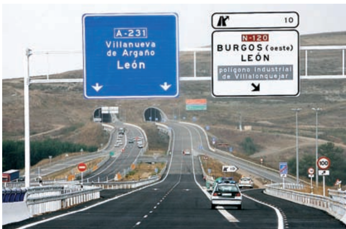
La nueva carretera, de 5,3 kilómetros de longitud, ha tenido una inversión de 30 millones.
