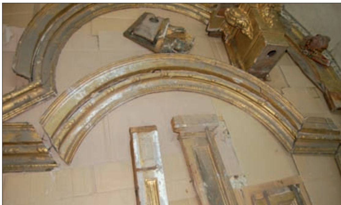
El estado de los retablos y los frentes al comienzo de los trabajos
