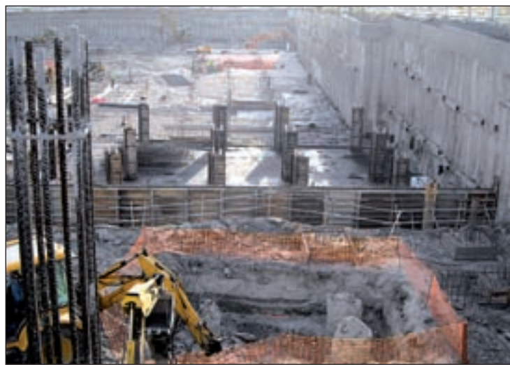
Una de las promociones en construcción en el nuevo barrio
