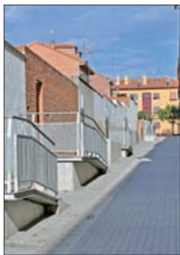
Resultado final de los trabajos
