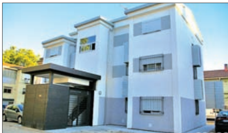
El edificio rehabilitado de la calle de Guadalaviar ESPINILLO.ORG
