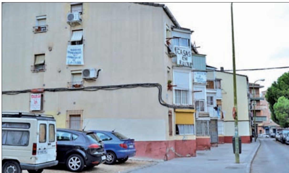
Una de las viviendas situadas en la calle de Escandón C.MARTÍNEZ/GENTE
