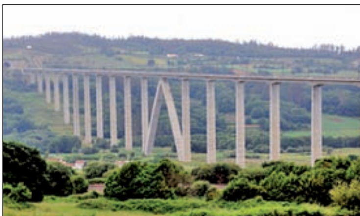
Viaducto de O'Eixo de la LAV Madrid-Galicia
