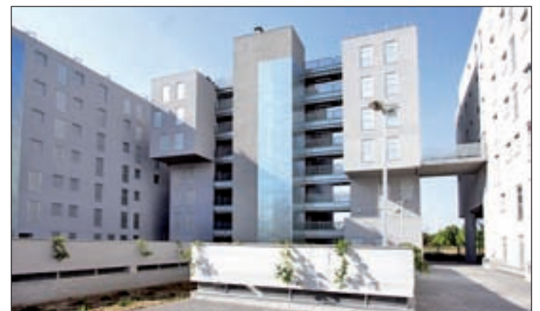
Algunas de las viviendas de la EMVS en La Catalana
