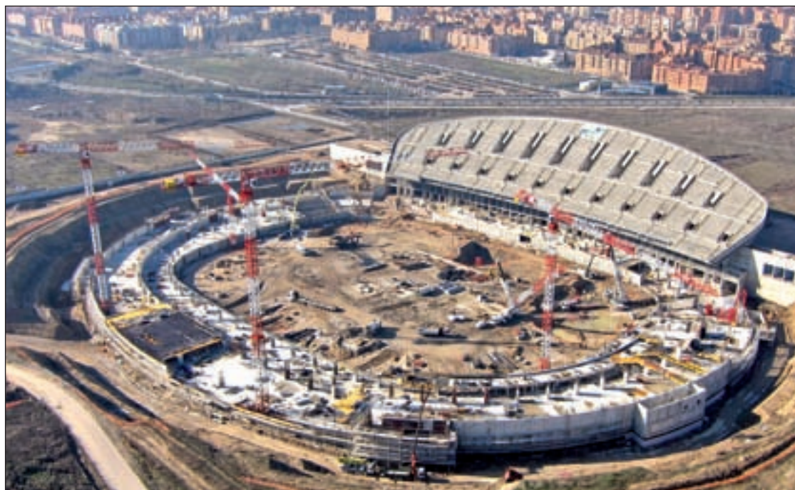
Estado actual de las obras del antiguo Estadio Olímpico
