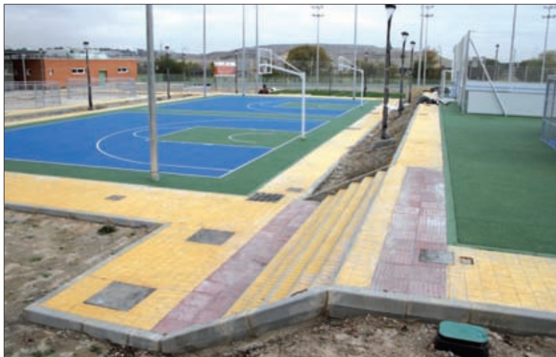
Las obras de construcción del polideportivo han entrado en su recta final RAFA HERRERO/GENTE
