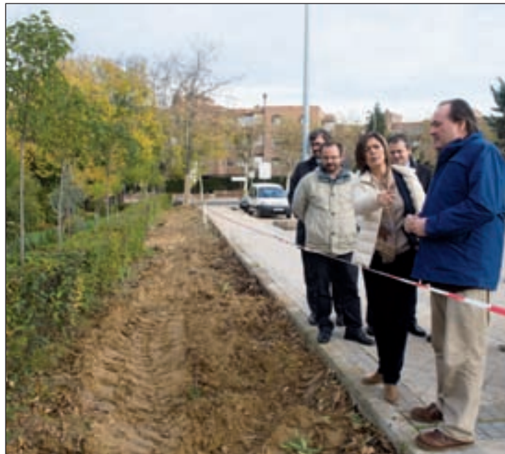
Tramo en construcción del futuro carril bici
