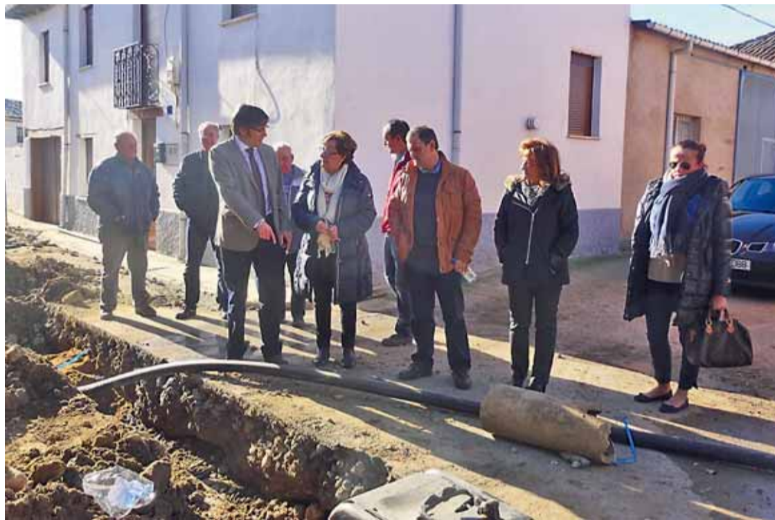
Emilio Orejas y varios diputados, en la visita a unas obras en el municipio de Santa Colomba de Curueño.
