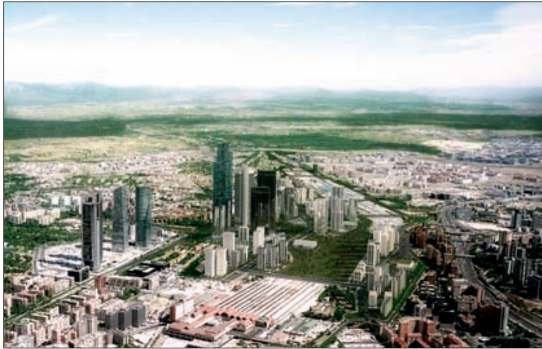
Adif asumirá la remodelación de la estación de Chamartín y el cubrimiento de las vías
