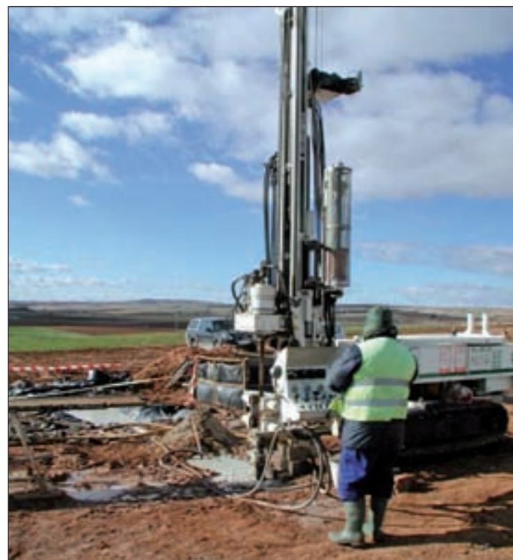
El ATC se está construyendo en Villar de Cañas
