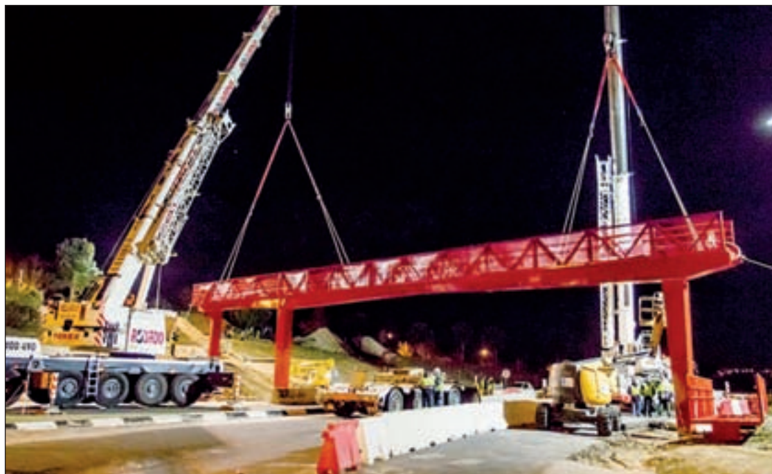
La instalación de la pasarela se produjo en horario nocturno
