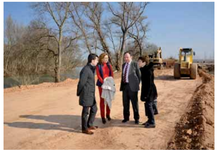
Sanz visitó las obras en la mota tras el desbordamiento del río.
