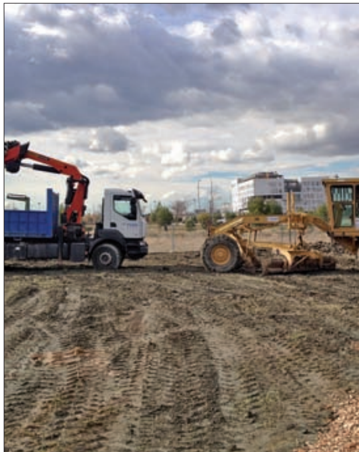
Las obras del colegio José Echegaray
