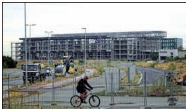
Estado actual del Centro Acuático, en San Blas-Canillejas
