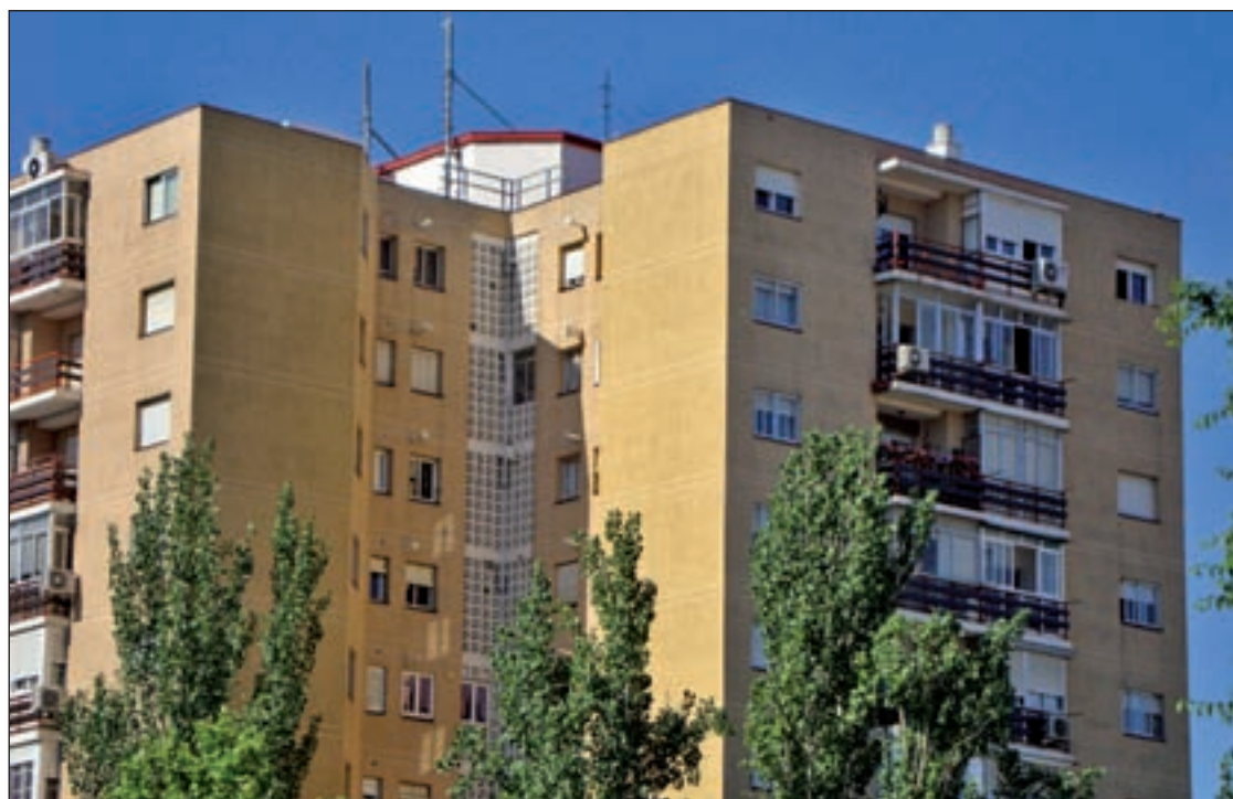
La azotea de la calle de Butrón, 31, tras el desmontaje de la infraestructura
