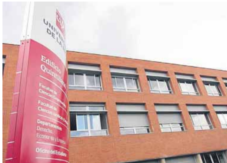
Edificio Quintiliano de la Universidad de La Rioja.
