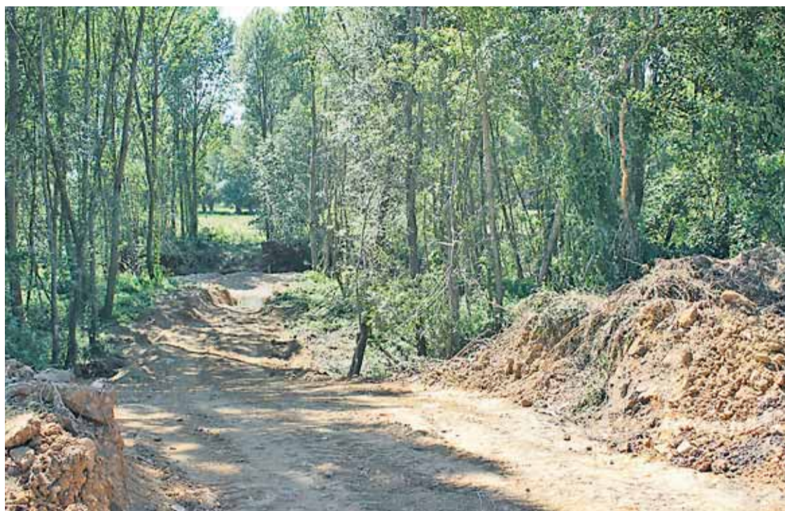
Tras los trabajos de desbroce en el Torío, se colocará el sifón para eliminar la fosa séptica y evitar vertidos.
