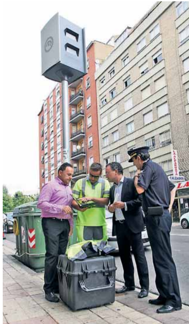
El concejal de Seguridad supervisa la instalación del radar fijo.
