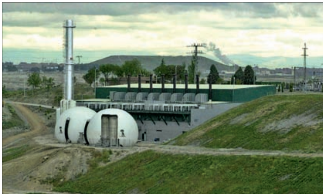
El Complejo Tecnológico de Valdemingómez, situado en el distrito de Villa de Vallecas
