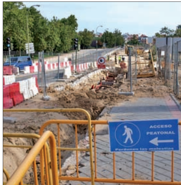
Imagen del estado de las obras AV CUATRO CAMINOS-TETUÁN
