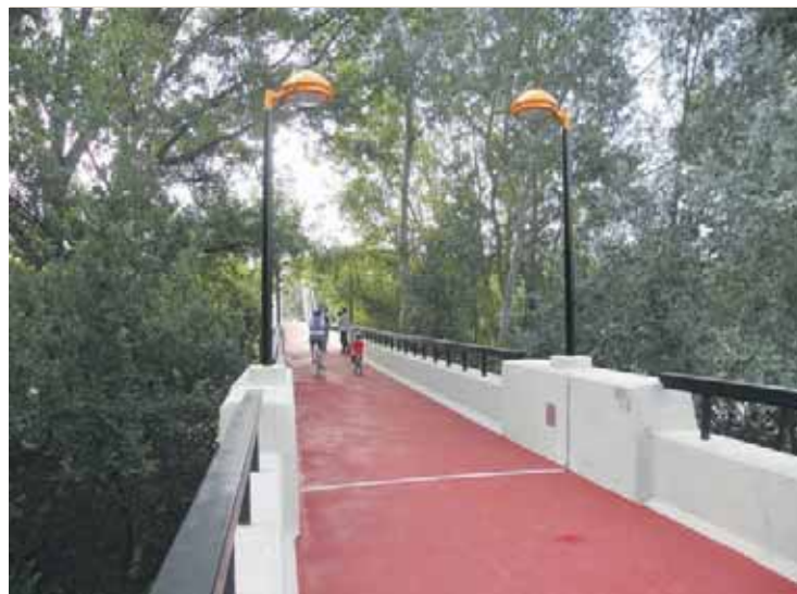
Las propuestas relativas al parque del Ebro son mayor vigilancia e iluminación y limpieza de farolas en el parque, calle Norte y Pasarela.
