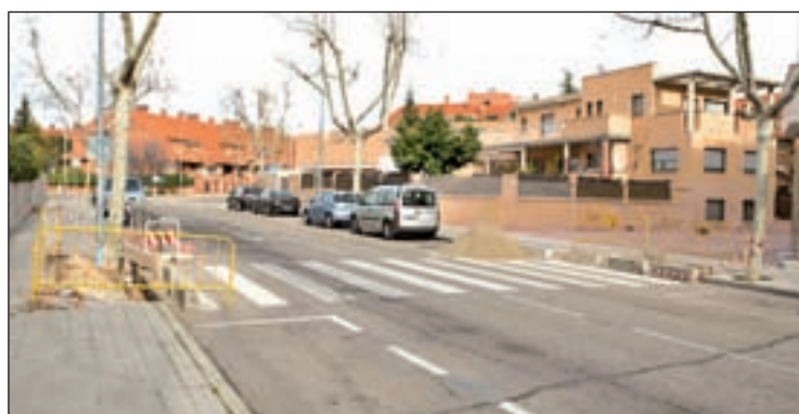
Trabajos de mejora en el barrio Santa Teresa
