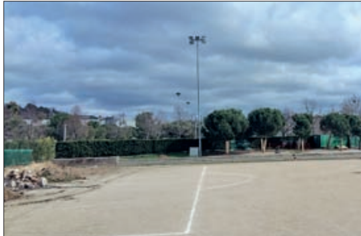
Estado actual de las instalaciones deportivas ACD SANFER
