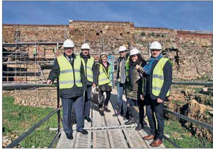
El alcalde de León visitó las obras de restauración de la Muralla.
