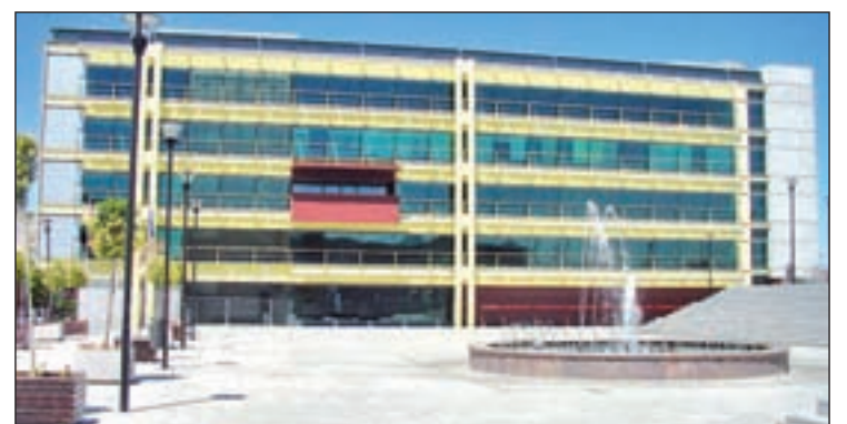
Fachada del Ayuntamiento de Fuenlabrada
