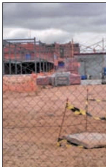
Obras del IES Manuel Fraga
