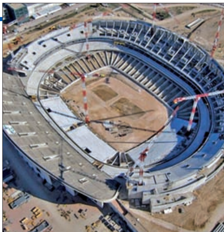
Vista aérea de las obras que se están realizando en el estadio
