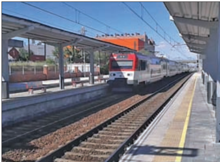
Estado actual de la estación de Renfe
