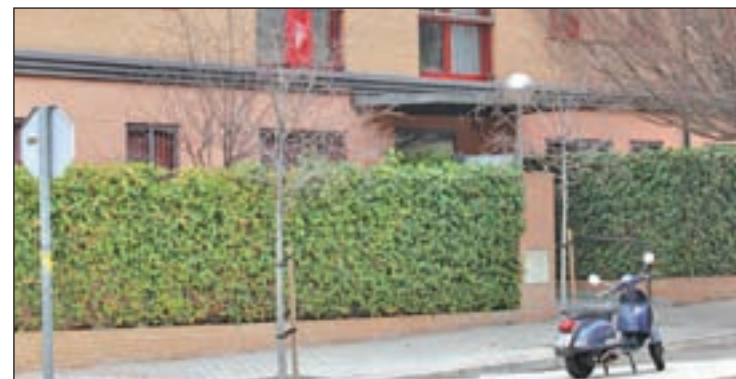
Viviendas en la Comunidad de Madrid
