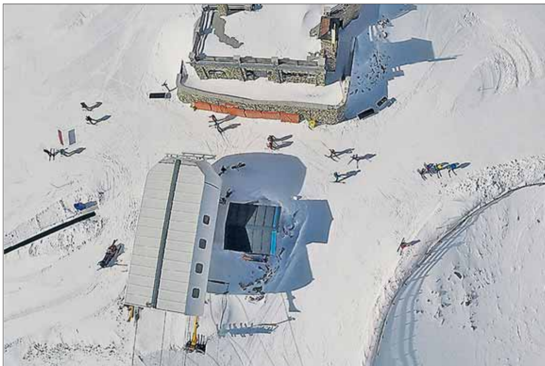
Imagen cenital obtenida mediante un dron en la estación de San Isidro el pasado 6 de abril con mucha nieve.
