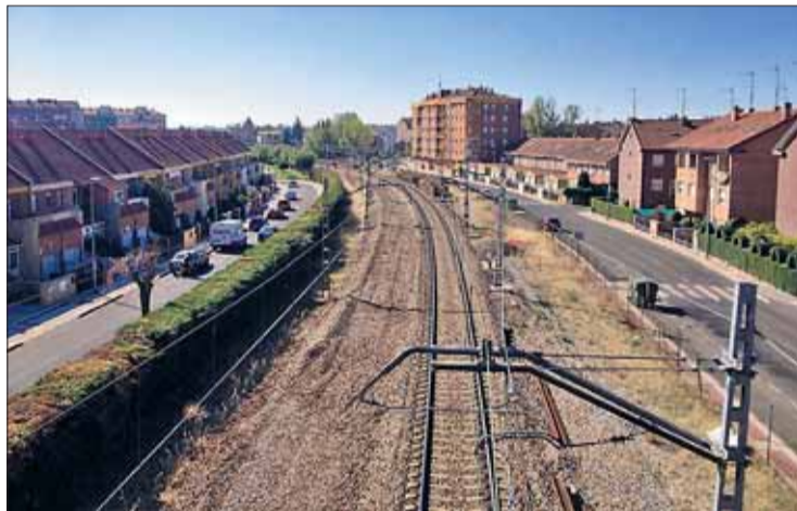
Vías del ferrocarril entre las calles Antonio Colinas y Limonar de Cuba de Trobajo del Camino, en el municipio de San Andrés del Rabanedo.
