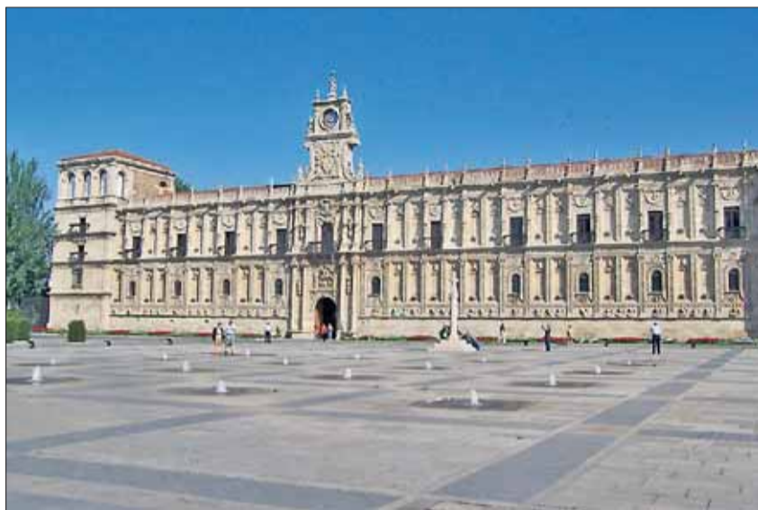
La fachada principal del Hostal de San Marcos será restaurada en los próximos meses.
