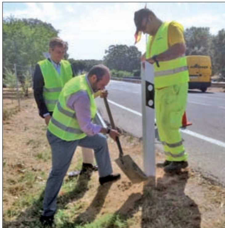
El consejero de Transportes en el inicio de las obras B. M./GENTE
