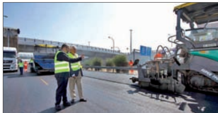
Pedro Rollán visitó las obras
