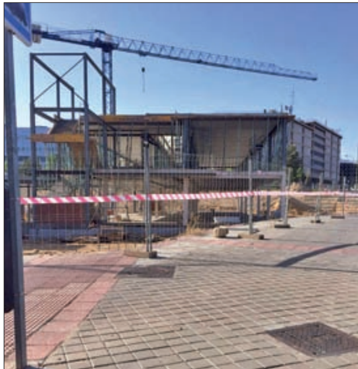
Estado actual de los trabajos en la segunda fase
