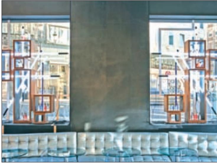
Las obras se pueden ver desde dentro y desde fuera del Hotel Urban
