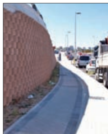
La zona afectada
