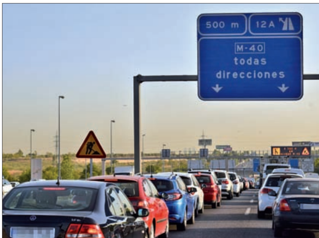
Obras en el enlace de la A-5 con la M-40 CHEMA MARTÍNEZ/GENTE
