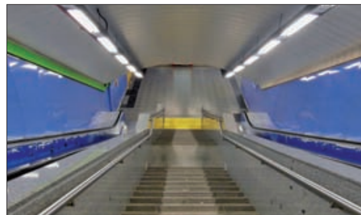
Escaleras mecánicas en la estación de Chueca
