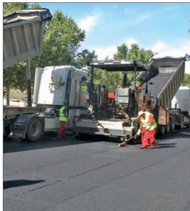
Trabajos de asfaltado en una calle de la ciudad
