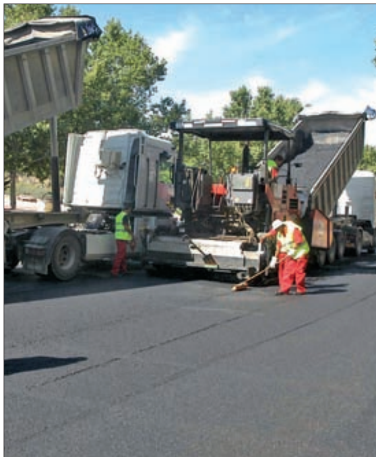
Trabajos de asfaltado en una calle de la ciudad
