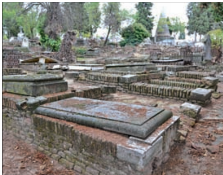
Estado de deterioro del cementerio de La Almudena
